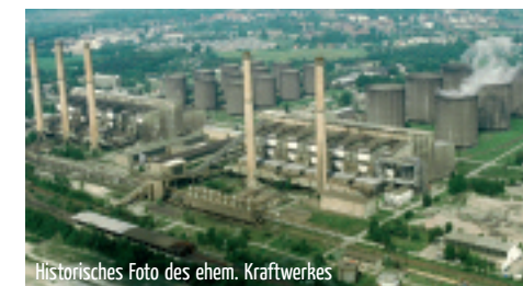
Historisches Foto des ehem. Kraftwerkes
